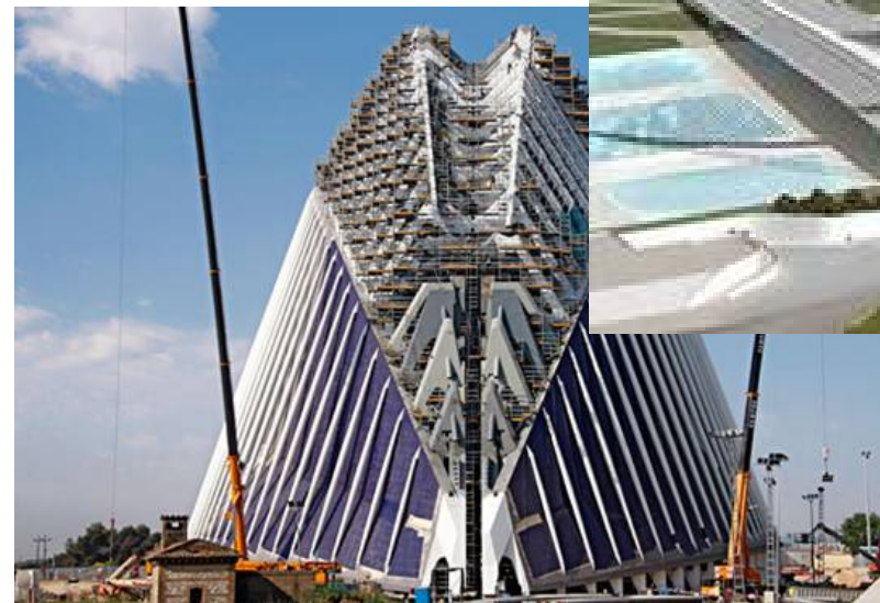
Estado del edificio en obras.
